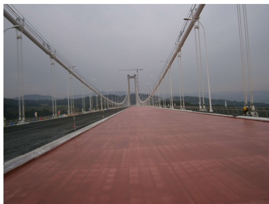
云南腾冲龙江大桥桥面防水粘结层
