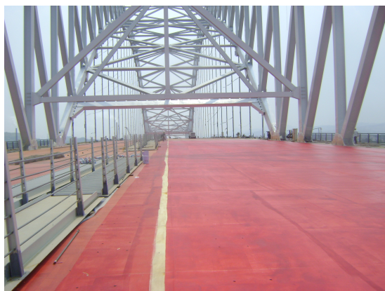
柳州维义桥桥面防水粘结层
