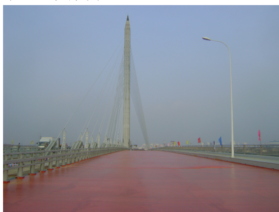
济宁梁济运河桥桥面防水粘结层
