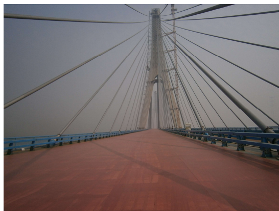
铜陵长江二桥（合福高铁公铁两用桥）防水粘结层
